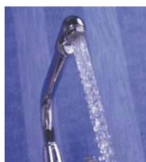
Proben vom Speicherablauf sollen erst entnommen werden, wenn nach ausreichend langem Spülen sichergestellt ist, dass stagniertes Wasser aus dem Ablaufrohr entfernt wurde.
